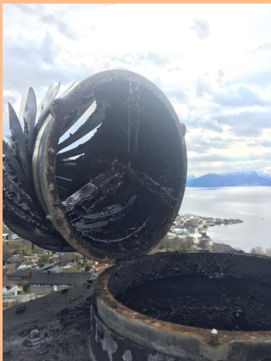
Foto: Gnistar frå fyring kan spreie seg utover tak og terreng når det er montert roterande pipehatt.
