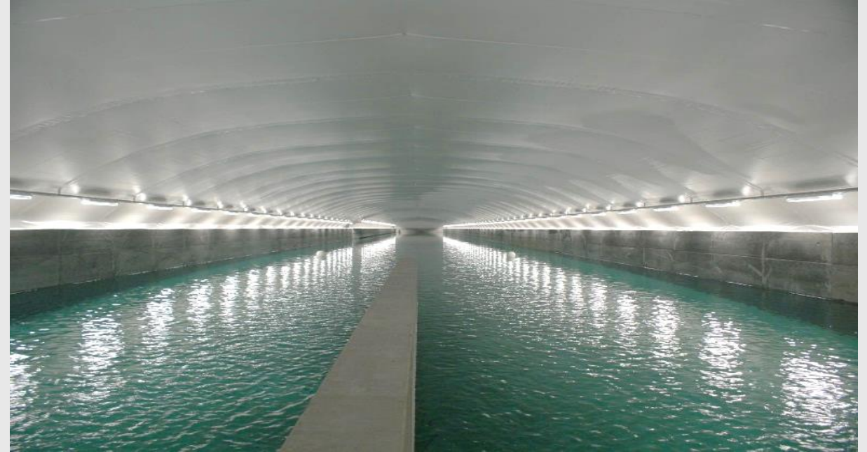
“Paraply” løsning med PVC Tunnelduk
