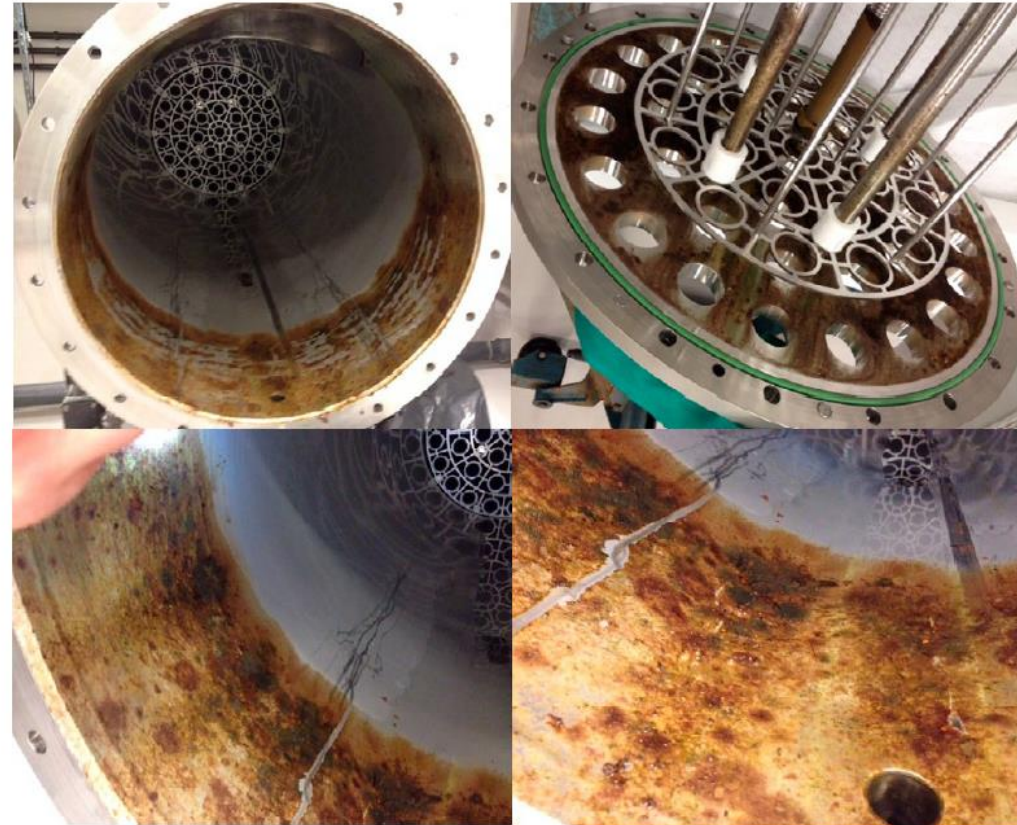
Figur 4-10. Begroing LP-aggregater ved ABV. Foto: T. Undrum.
