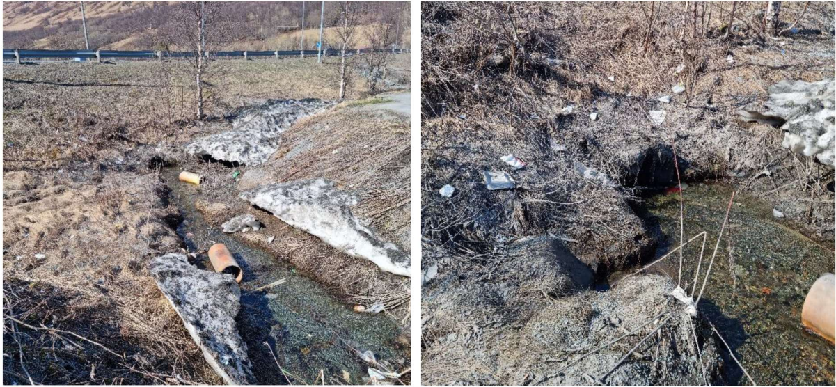
Figur 6: Bilder av innløp stikkrenne under E6, Roffabekken
