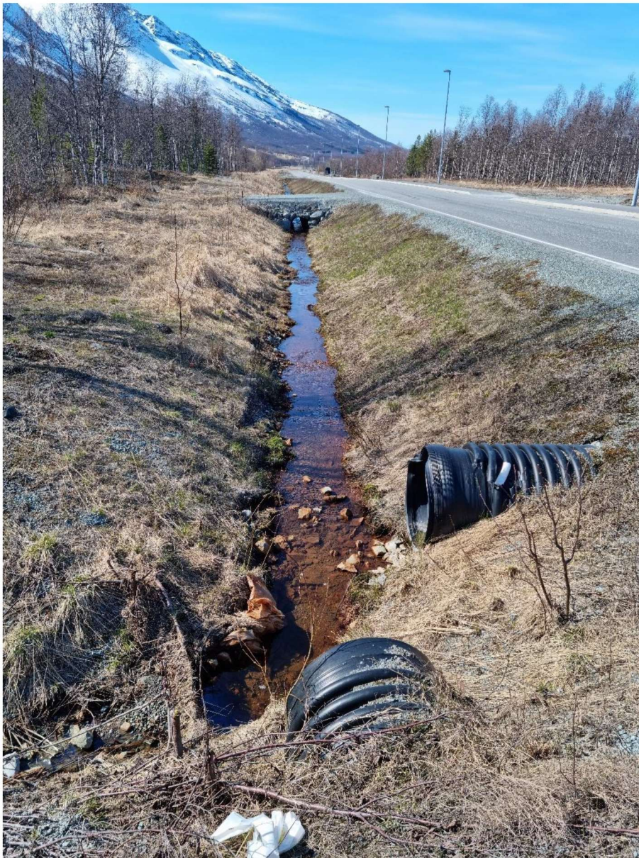
Figur 7: Bilder av stikkrenner langs og under Industriveien
