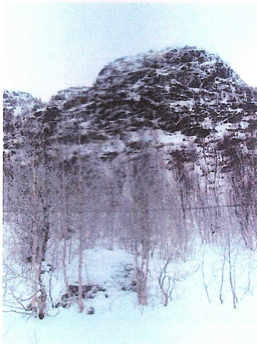
Foto nr 2. I forgrunnen sannsynlig blokk fra steinsprang som ligger på nedsiden av vegen.
