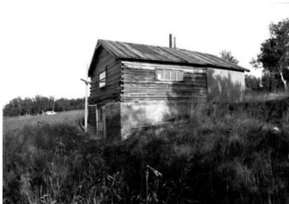
FIGUR 33 SEFRAK REGISTRERT BYGNING. HUS FOR STORFE, SAU OG GEIT
