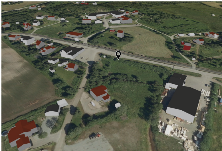
Figur 7 Eksisterende bygningsvolumer sett mot nord (Kilde: www.3d.kommunekart.com )
