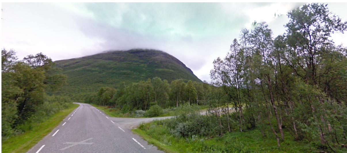
Kryss Fv 87 og kommunal veg som fører ned til anlegget (Kilde: Google Maps)
