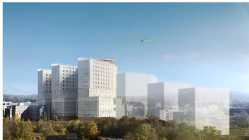
HØYHUS PÅ HØYHUS: De tre bygningene til venstre skal stå ferdig i 2029. 76 meter tilsvarer 16 sykehusetasjer.
