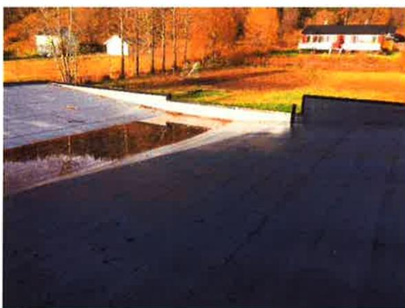
Figur 2.2.1-12 – Flattak med folietekking
