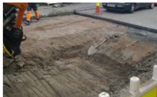
Utkiling med 50 cm kant til asfalt
