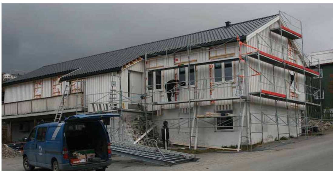
BYGGET: I høst ble det skiftet ytterpanel og vinduer i MC-klubbens klubbhus.
