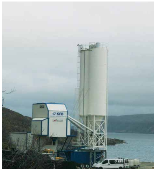
BETONG: Det er produsert enorme mengder betong ved den mobile betongstasjonen.
