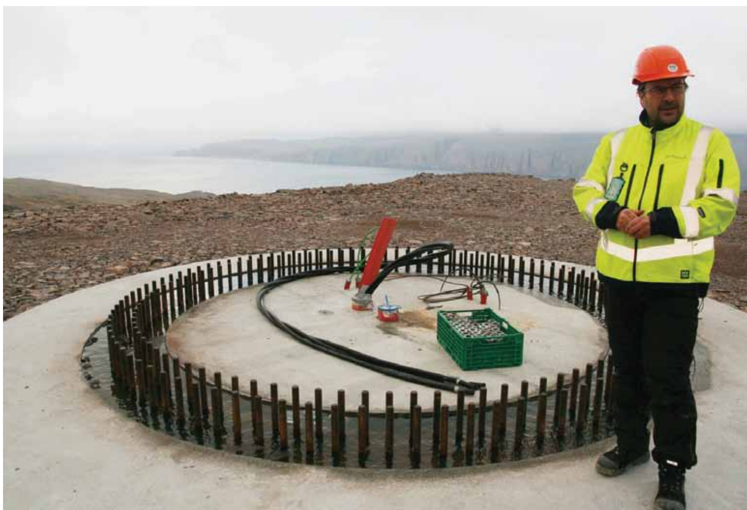
DIMENSJONER: Fundamentene til vindkraftturbinene har virkelig store dimensjoner.
