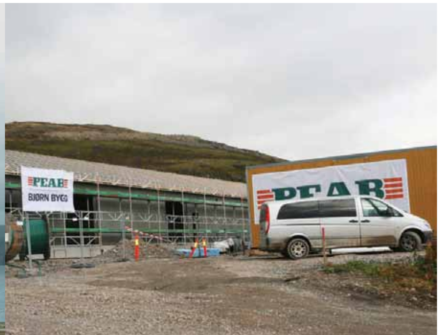
SERVICEBYGG: Fra dette servicebygget styres vindkraftverket.
