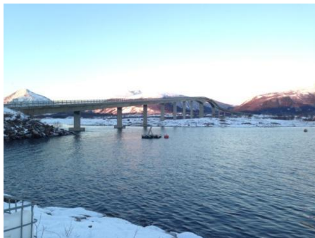
Engeløybrua og Bogøya sett fra Storskjæret.
