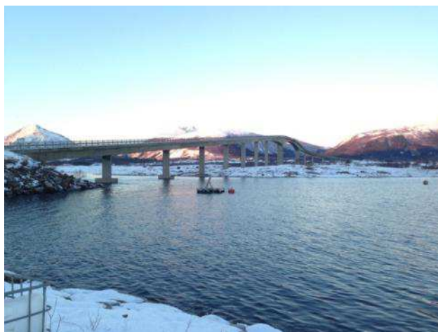
Engeløybrua og Bogøya sett fra Storskjæret.
