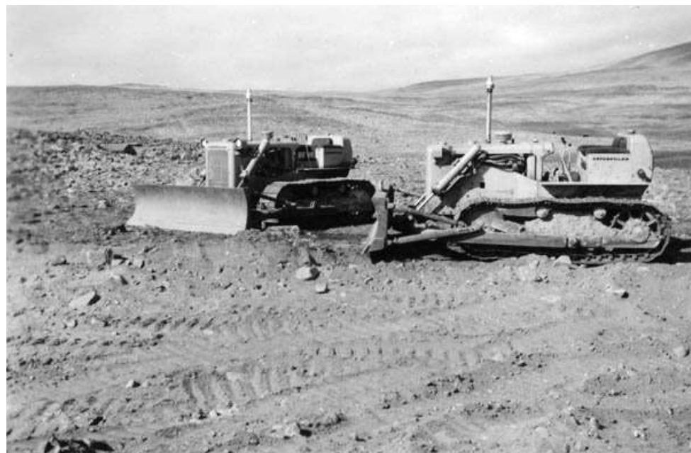
Bulldoserne som ble brukt i arbeidet på veien.
