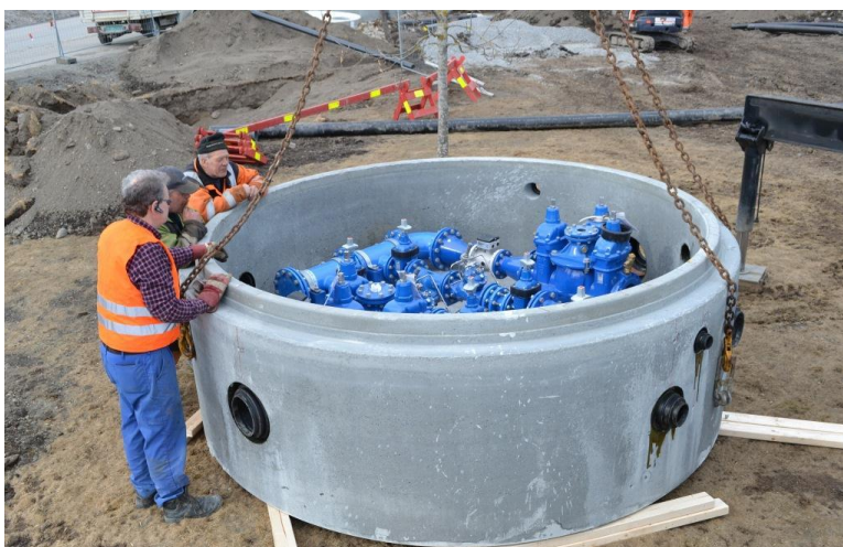
Figur 1.3.3 Montering av vannkum for trykkreduksjon- og sonevannmåling i Fagerlundkrysset i 2011
